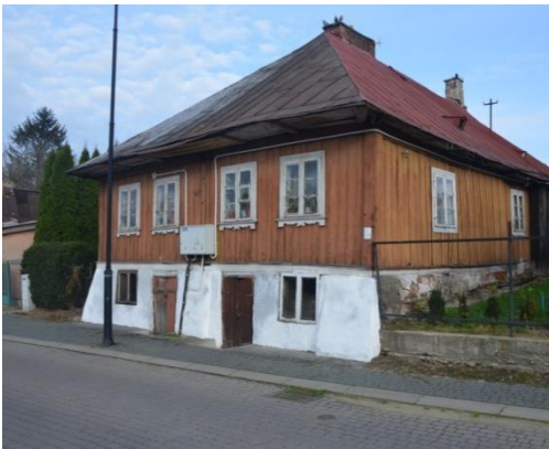
Fig. 19. Wooden inn at Plac Kanałowy St. 18
