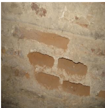
Fig. 7. Breking bricks
